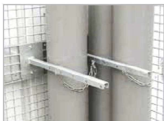
Supports pour bouteilles avec chaînes de sécurité font en sorte que les bouteilles ne puissent pas basculer.
