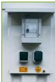
Les kits d'installation électrique sont selon leur exécution destinés à des besoins spécifiques. Les exécutions pour le stockage de produits inflammables comprennent entre autre une lampe murale ATEX.
