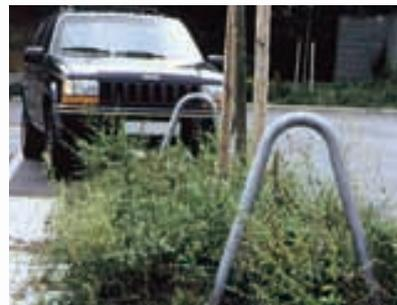
**Arceau de protection des arbres, tube d'acier Ø 60 mm x 2,5 mm,**
