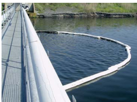
Plusieurs barrages forment une barrière de protection pour entourer et contrôler le déversement.
